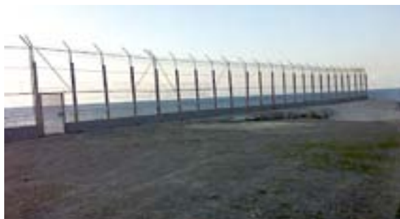
Clôture à Ceuta (Espagne)
